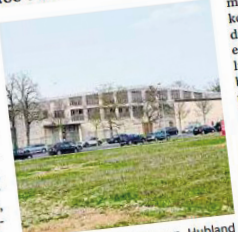
Der ehemalige Hangar am Hubland wird nicht neu gebaut, sondern saniert. Foto: Thomas Obermeier
